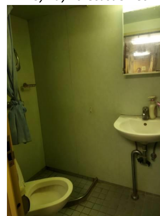
Bathroom cabin n°309
